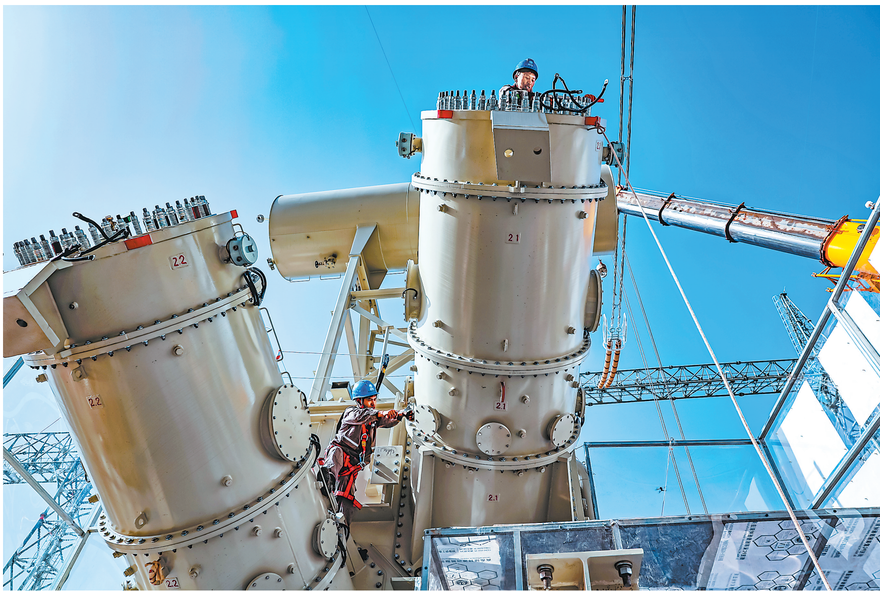
施工人员正在对换流变压器附件进行螺栓紧固作业。
