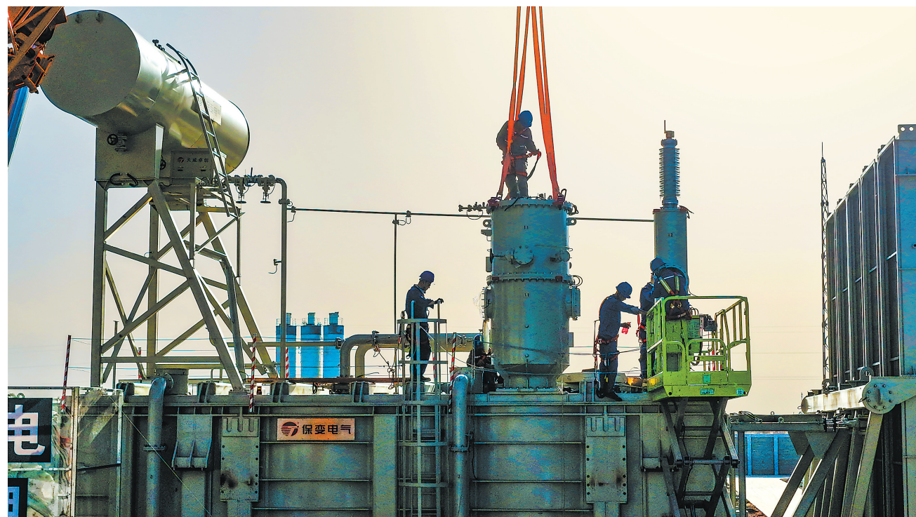
极II高端换流变网侧升高座吊装。
