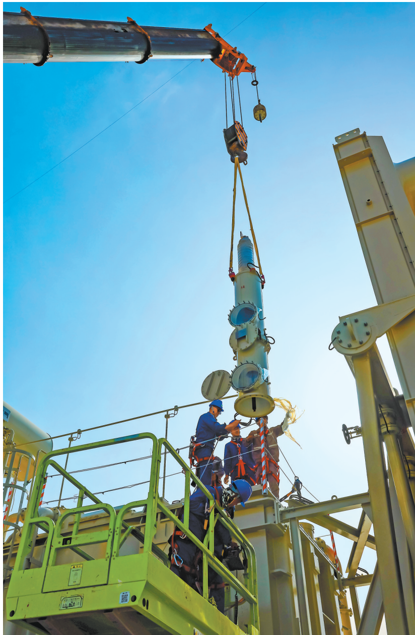
换流变压器附件吊装作业。
