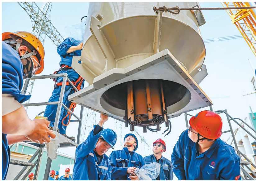
施工人员检查换流变网侧升高座绝缘件。
