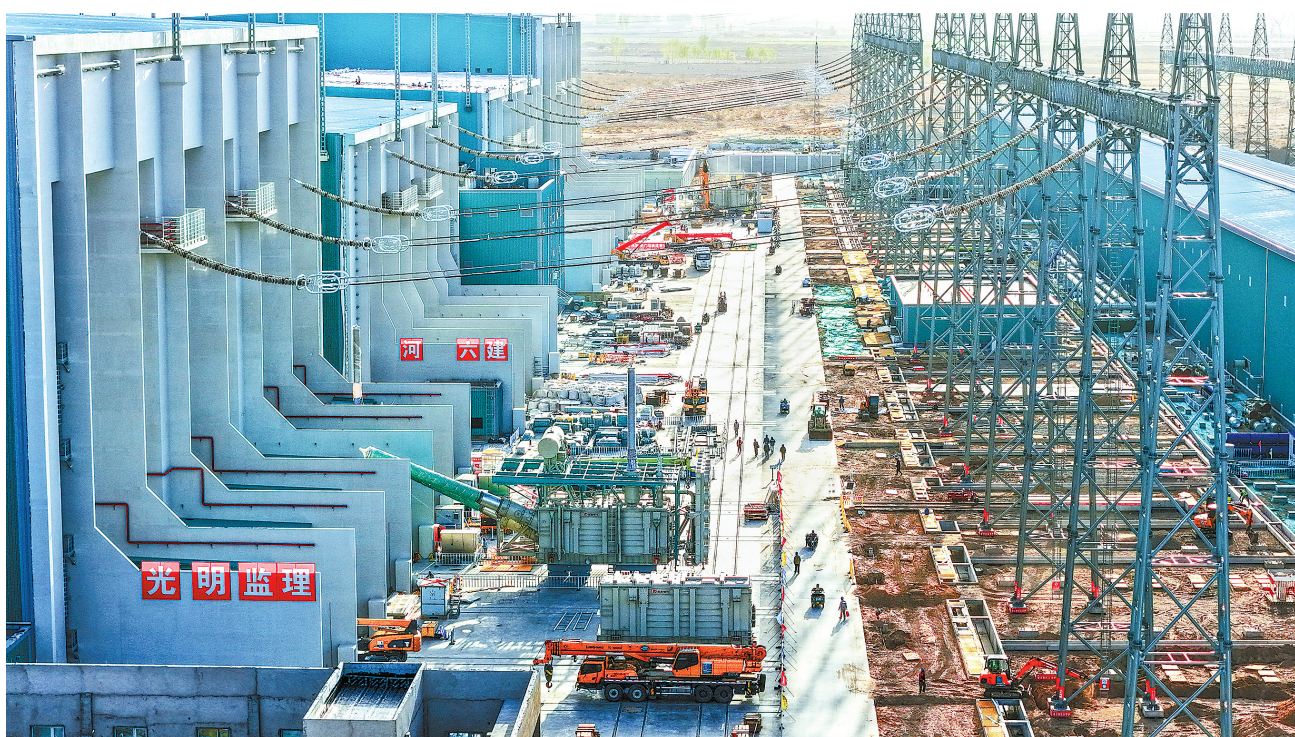
陇电入浙工程武威±800千伏换流站建设现场一派繁忙。
