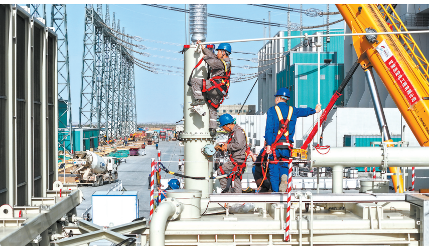
施工人员正在安装换流变压器附件。
