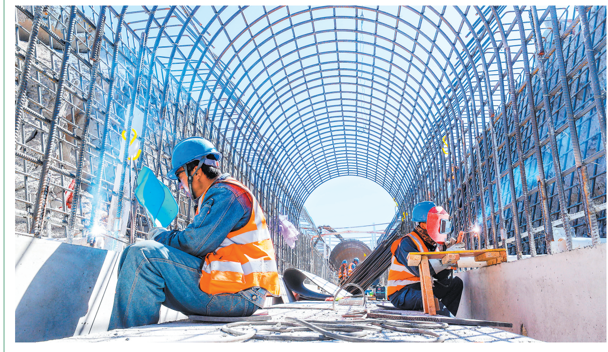
五月三日,张掖市盘道山抽水蓄能电站项目建设现场,工人正在进行焊接作业。新甘肃·甘肃日报通讯员王将
