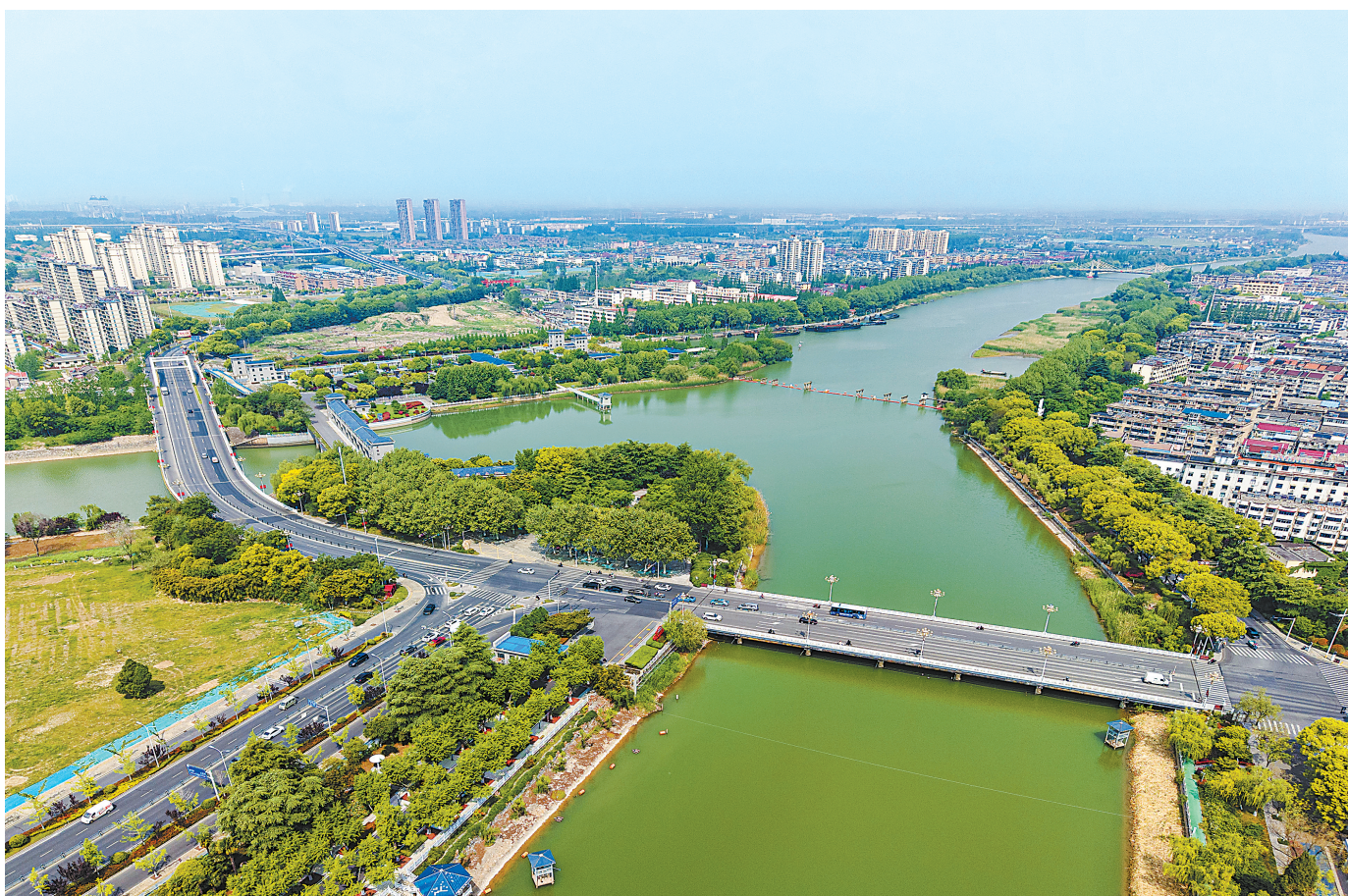
这是4月27日拍摄的位于江苏省扬州市江都区的南水北调东线输水通道高水河。当日,根据南水北调东线一期工程2026年4月水量调度方案,江苏省江都水利枢纽工程管理处启动新一轮调水,南水北调泵站同步启动调水。新华社发
