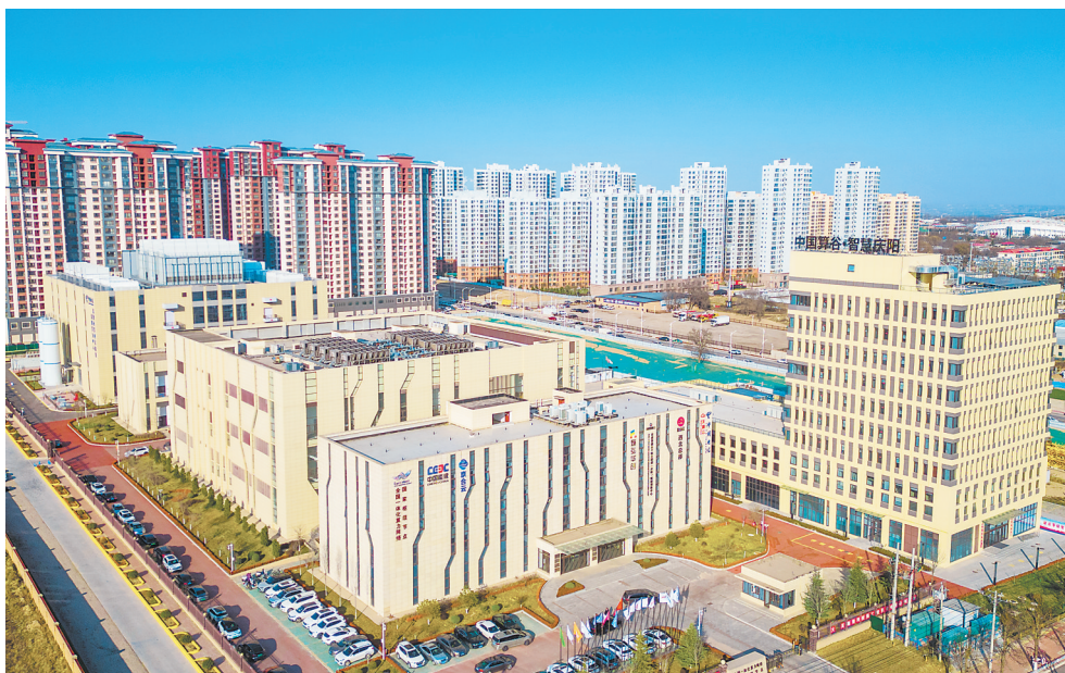
庆阳全国一体化算力网络国家枢纽节点“东数西算”产业园。新甘肃·甘肃日报记者 丁凯
