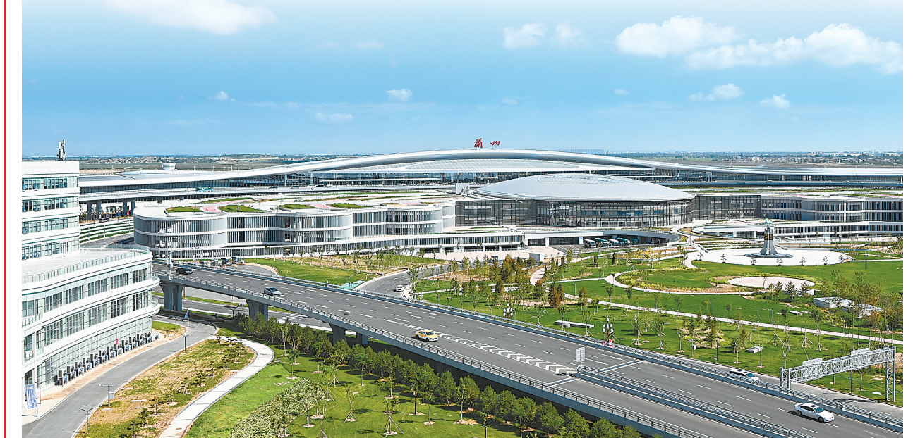
兰州中川国际机场三期扩建工程的投运，为繁忙的空中丝绸之路搭建起更加开放的平台。 新甘肃·甘肃日报记者 丁凯
