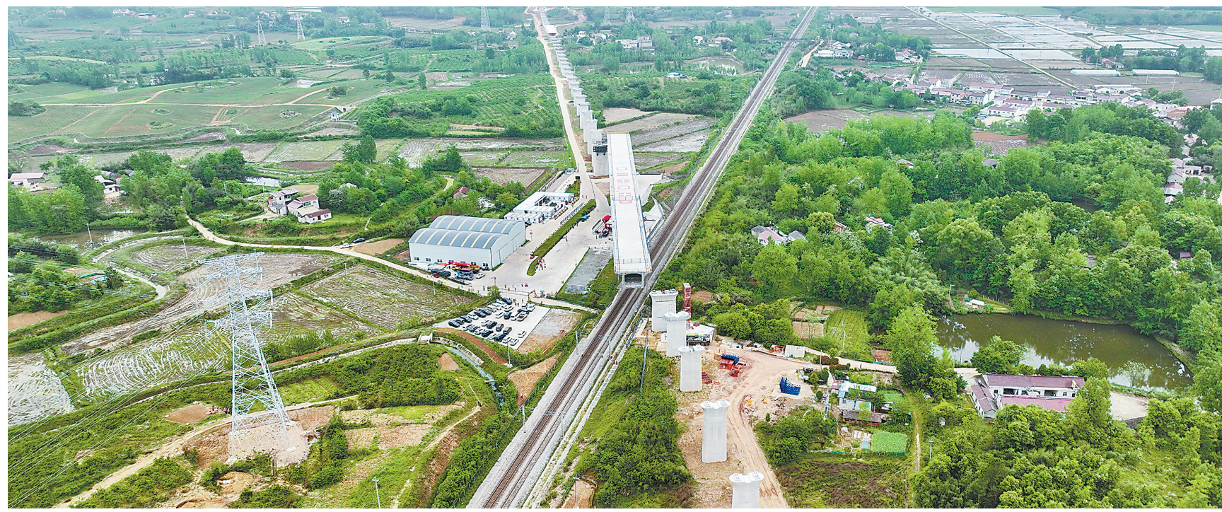
4月21日拍摄的合武高铁跨宁西铁路万吨连续梁特体施工现场。合肥至武汉高速铁路是我国“八纵八横”高铁网沿江通道的重要组成部分,线路建成后,将在合肥至武汉间形成新的高铁大通道,进一步优化长江经济带铁路网布局。新华社发
