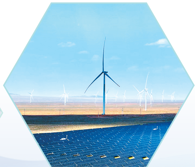
临泽北滩新能源产业项目现场。 (资料图)
