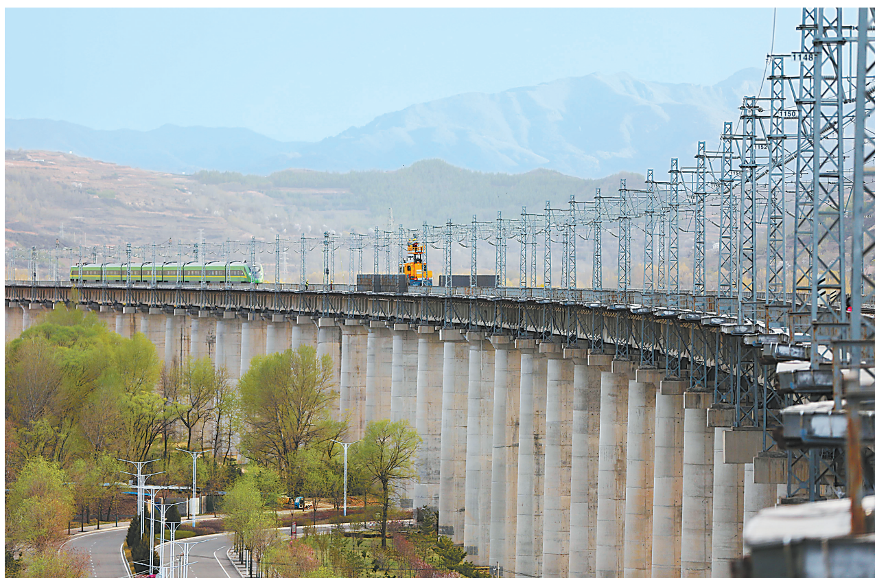
4月17日,兰州供电段职工在兰渝铁路甘肃省定西市渭源县境内进行接触网集中修作业。
