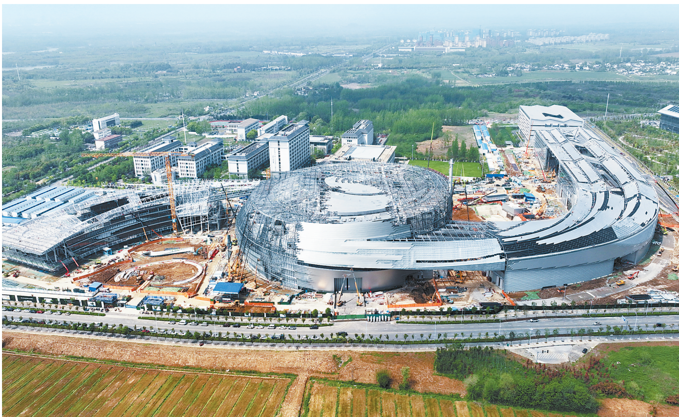
4月15日拍摄的紧凑型聚变实验装置(BEST)建设现场。近日,位于安徽省合肥市未来大科学城的紧凑型聚变实验装置(BEST)建设稳步推进。作为我国下一代“人造太阳”,BEST装置肩负着实现等离子体“燃烧”的使命。
