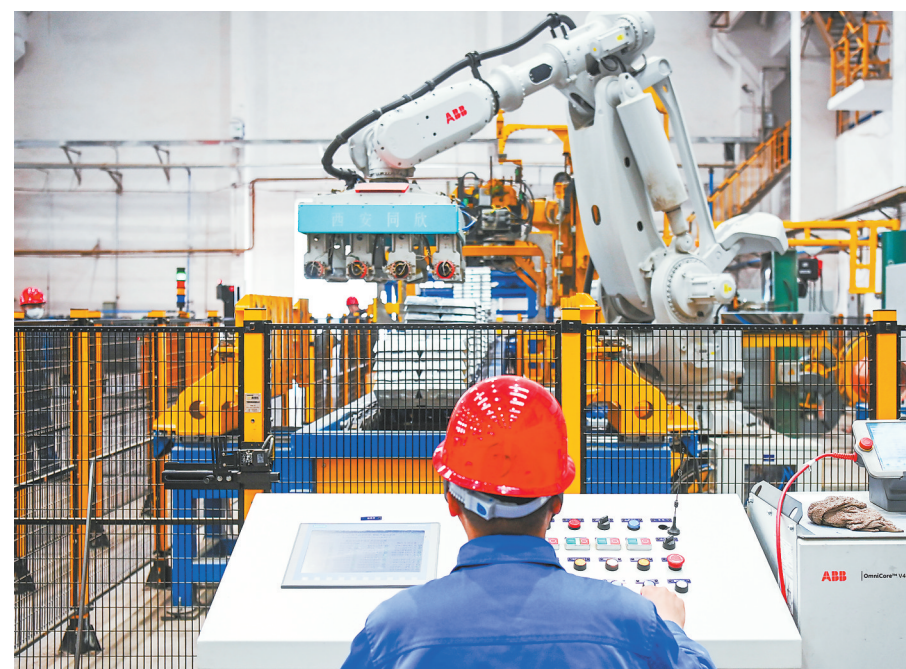
西北铅锌冶炼厂熔铸车间自动化生产线。
