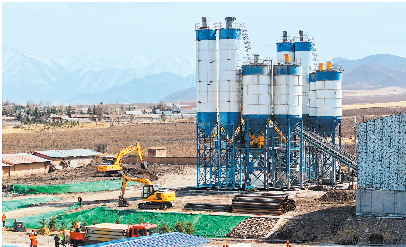
4月7日,民乐县张高高速混凝土拌合站项目建设正酣。
