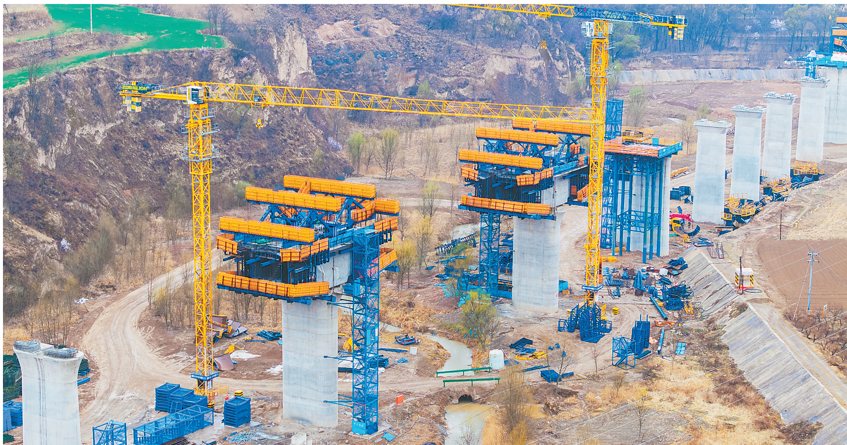
近日,平庆铁路镇原段桥梁主体工程进入冲刺阶段,施工人员正在加紧施工。 新甘肃·甘肃日报通讯员 陈飞
