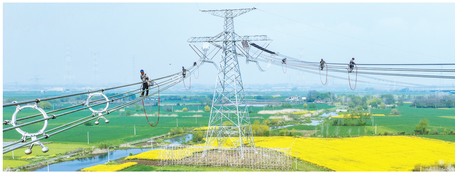
4月1日，在安徽省芜湖市繁昌区，电力工人在甘肃—浙江±800千伏特高压直流输电工程施工现场作业。
