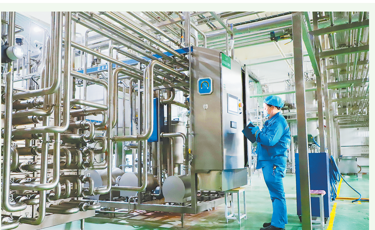
3月26日,张掖市甘州区甘肃祁连山乳业有限公司生产车间,工人保障全自动生产线高速运行。
