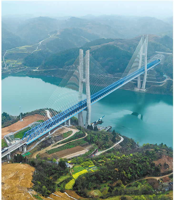
3月24日,陕西西安至湖北十堰高速铁路湖北段正式启动联调联试,全线进入开通运营倒计时。图为检测列车驶过西十高铁汉江特大桥。
