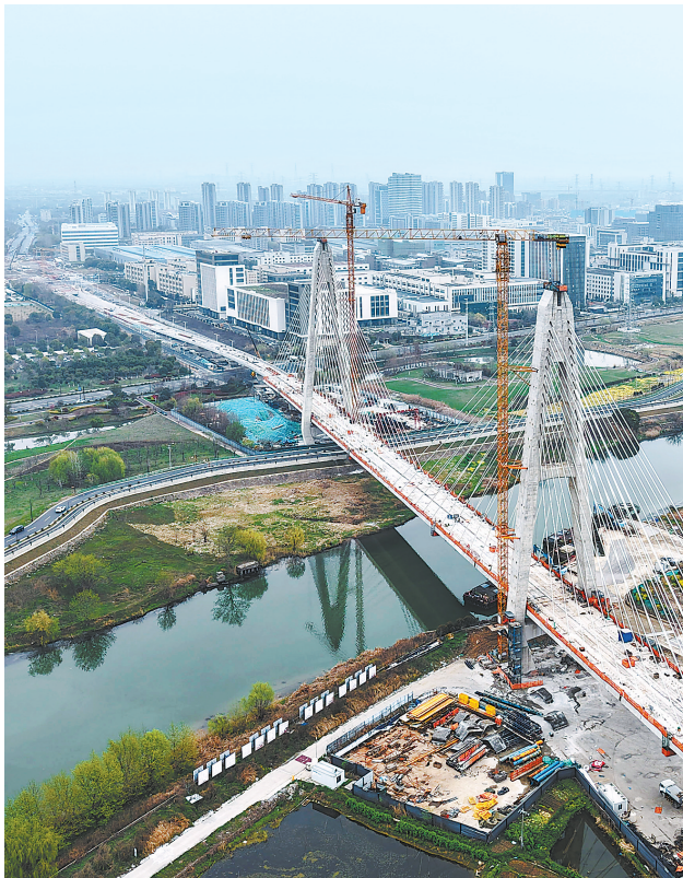
3月22日拍摄的杭州至德清市域铁路施工现场,一款新能源多场景闪光焊机首次在钢轨上开展焊接作业。 新华社发
