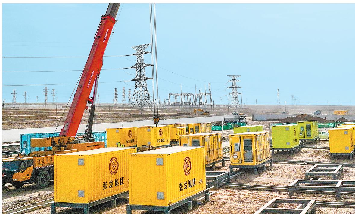
近日,山丹东乐辉通独立储能电站项目电池仓吊装作业全面展开。
