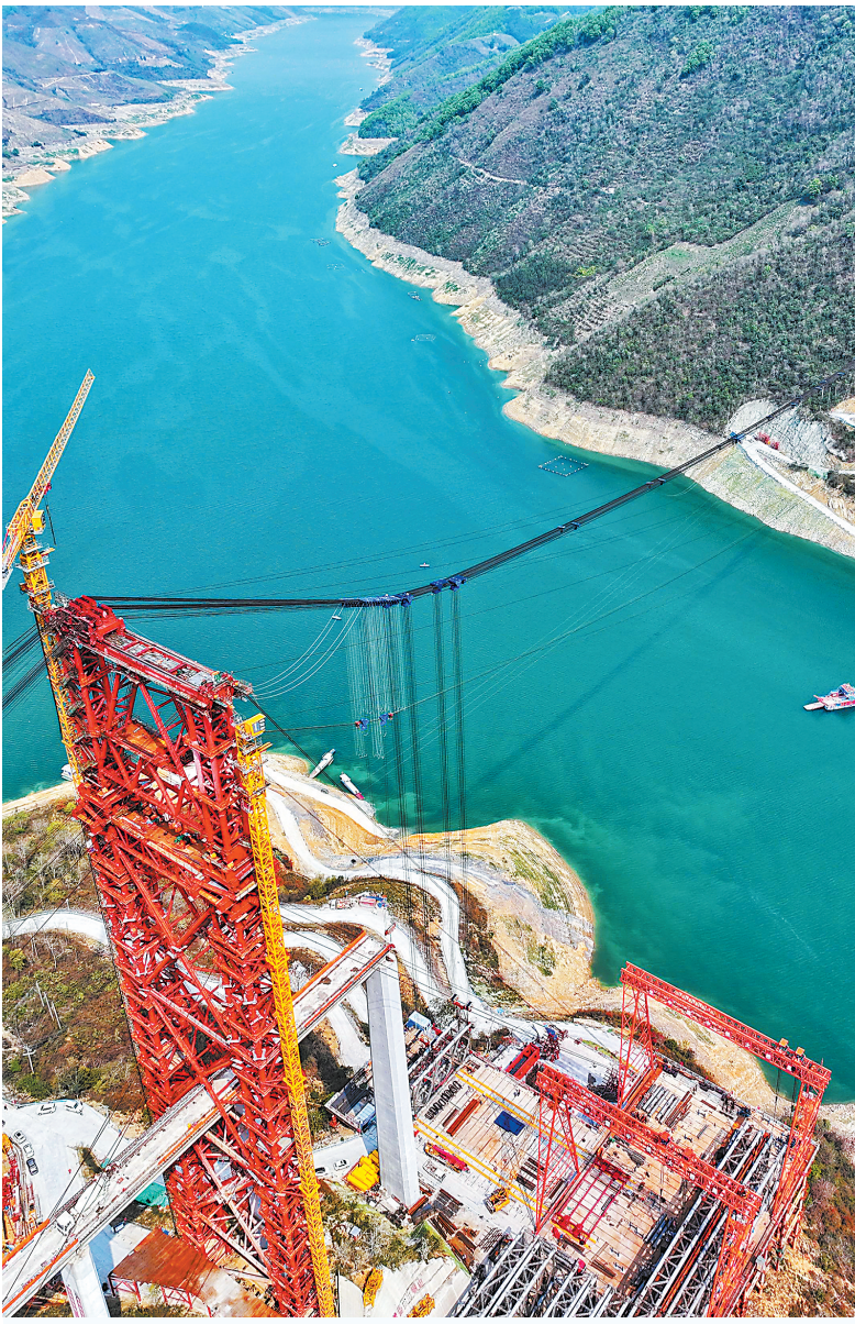
3月21日,黄(桶)百(色)铁路控制性工程——红水河铁路大桥首节拱肋成功吊装。
