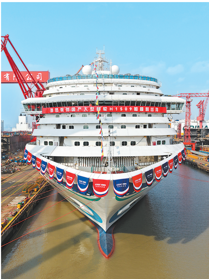
3月19日拍摄的第二艘国产大型邮轮“爱达·花城号”(无人机照片)。3月20日,第二艘国产大型邮轮“爱达·花城号”在上海出坞。这意味着该船的船体结构完整,已具备航行能力,全面转入码头调试阶段。“爱达·花城号”计划于今年底完成交付,将在广州南沙邮轮母港开启国际航线。新华社发
