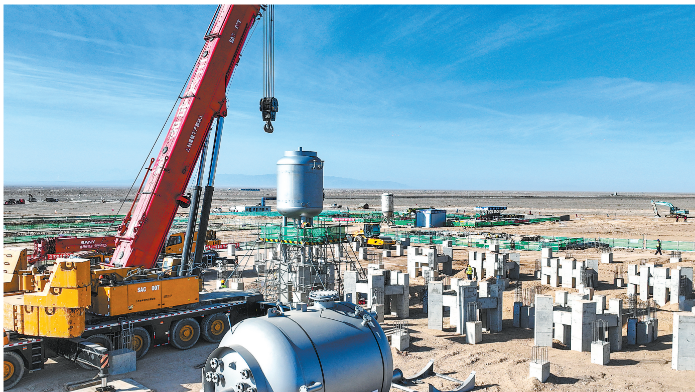
3月17日，中核汇能金塔县160万千瓦清洁能源保障项目建设现场，工人在加紧施工。
