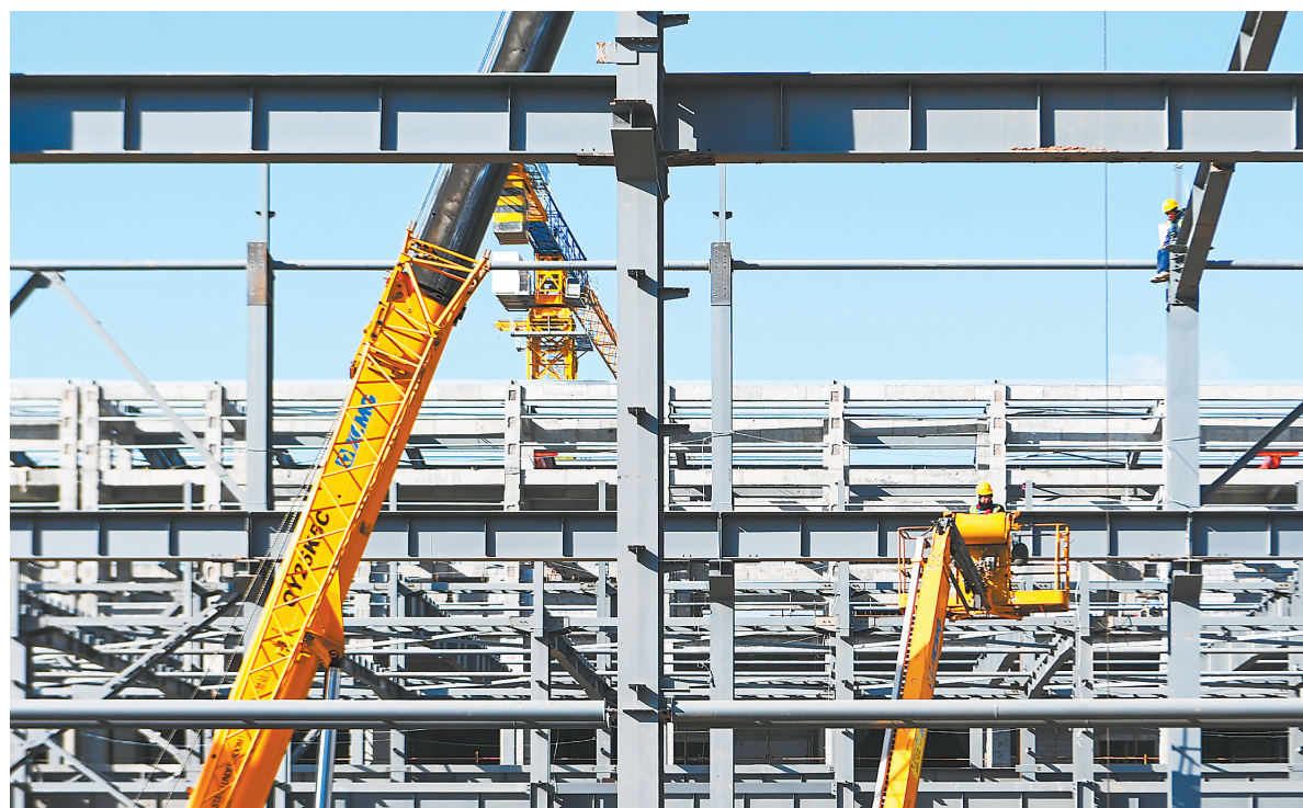
省级重大招商引资项目——甘肃宝镁西铁合金有限公司年产30万吨高品质硅铁合金项目建设现场。
