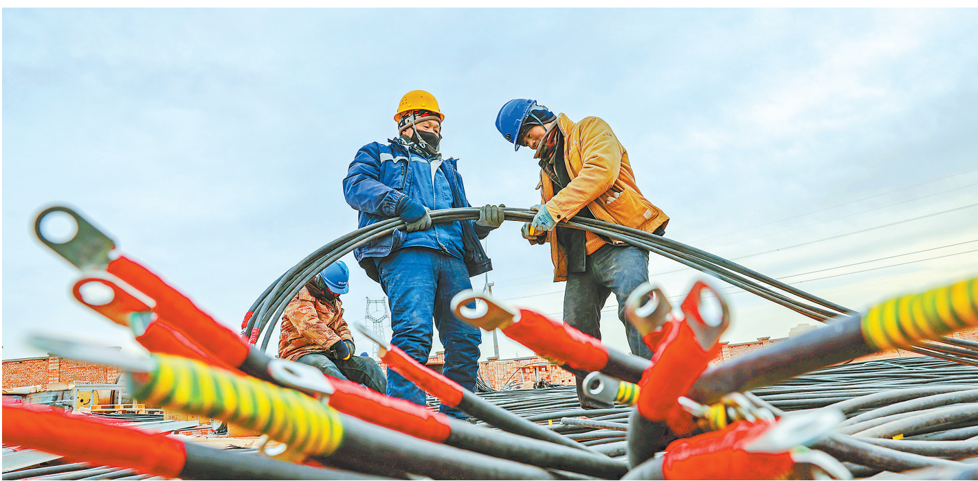
华景丝路300MW/1200MWh独立储能电站项目建设现场,施工人员进行安装调试作业。
