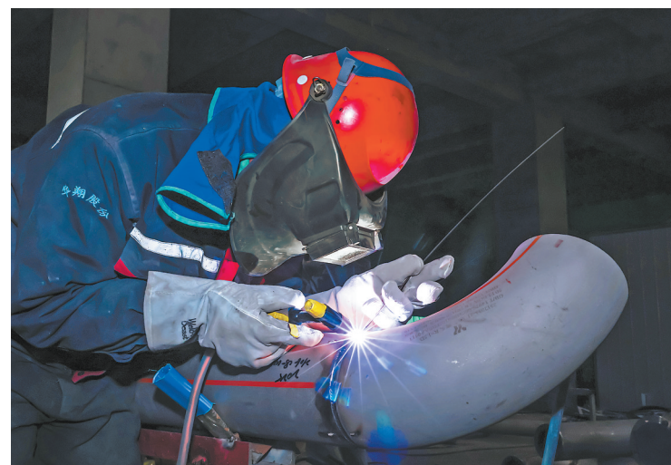
甘肃巨化新材料有限公司高性能硅氟新材料一体化项目建设现场,工人进行设备焊接作业。
