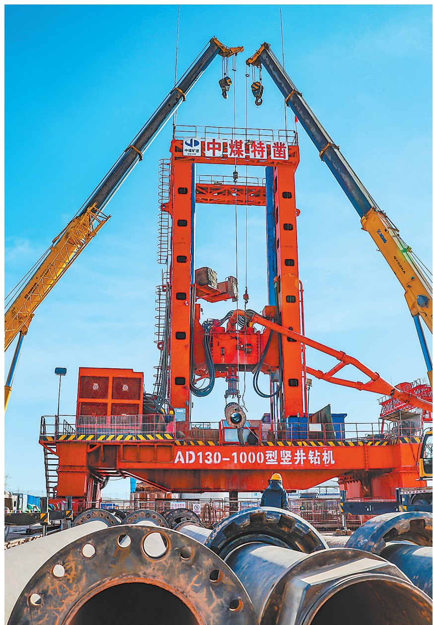
张掖青阳煤矿项目施工现场,工人们开展钻井钻探作业。
