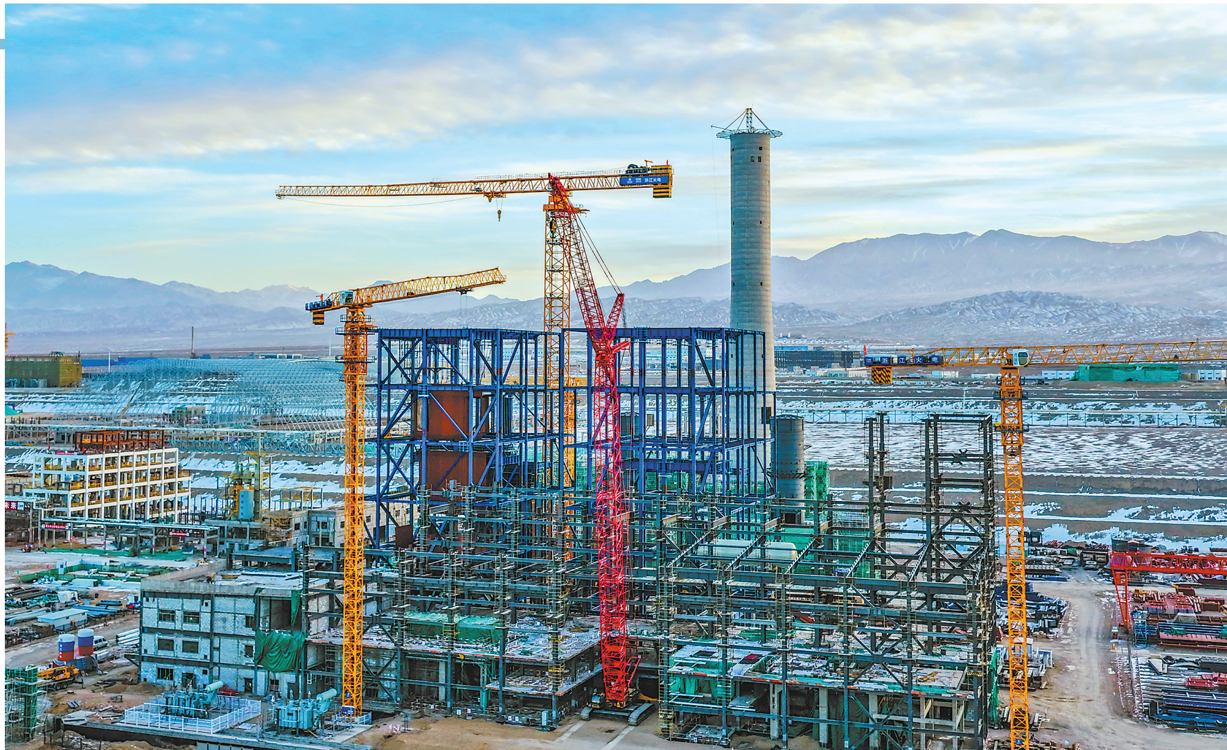
甘肃巨化新材料有限公司高性能硅氟新材料一体化项目建设现场。
