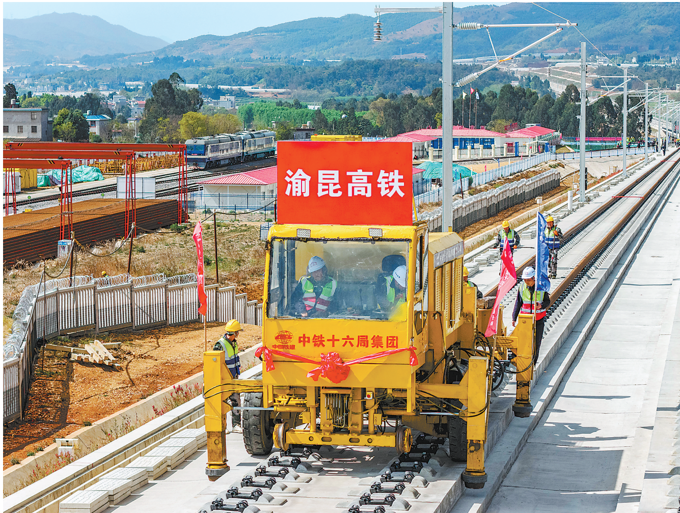
3月18日,在位于云南省昆明市嵩明县的渝昆高铁施工现场,第一对500米长钢轨稳稳落在无砟轨道上,渝昆高铁云南段正式开始铺轨。渝昆高铁线路开通运营后,重庆到昆明的行车时间将压缩至两个半小时左右。
