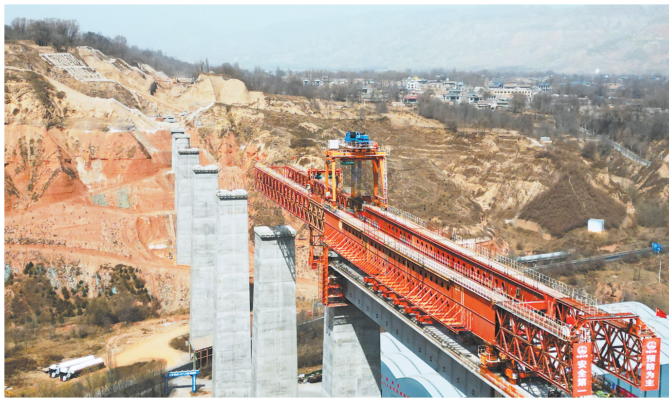
兰合铁路4标段加紧施工。
