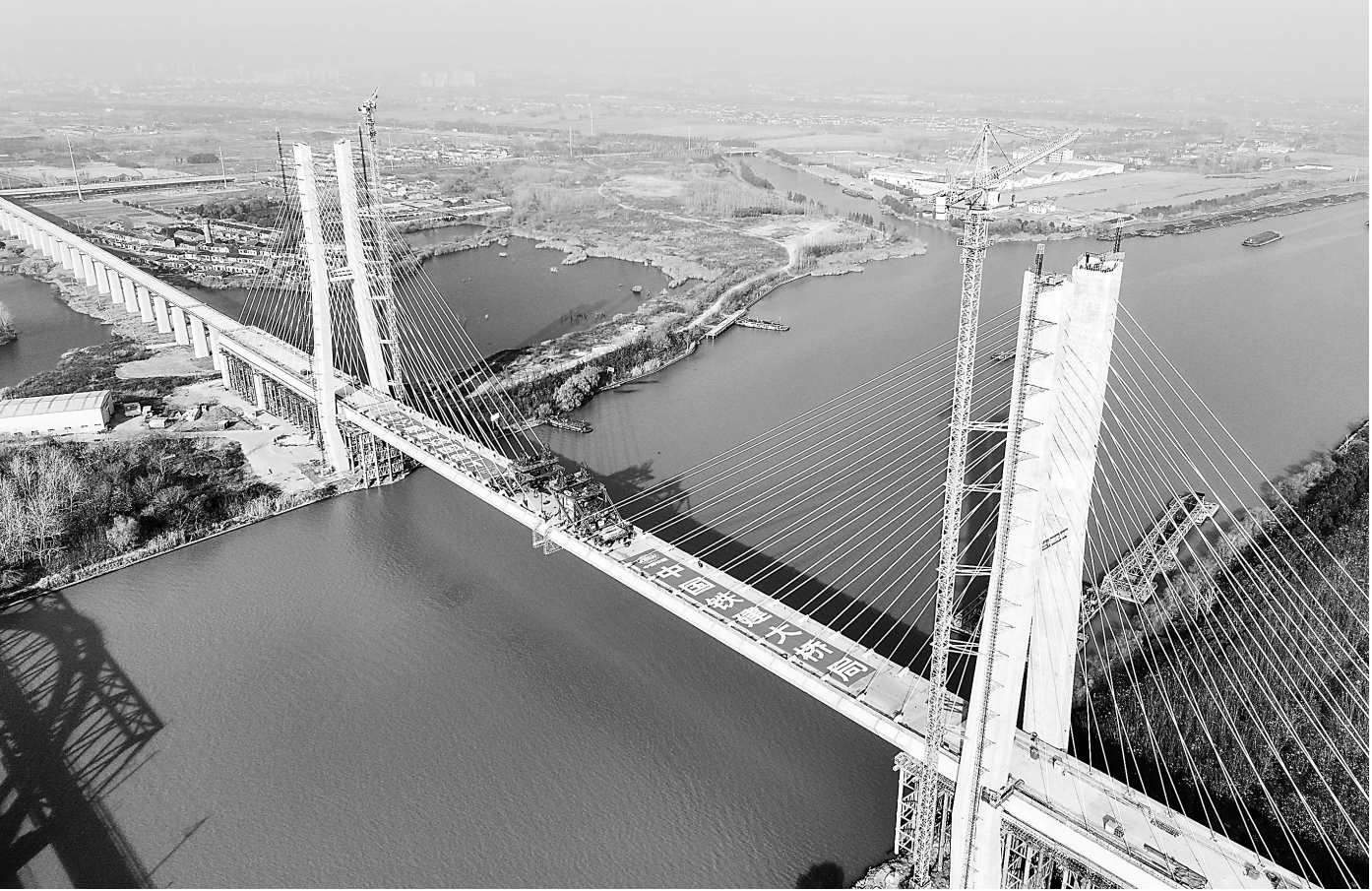
12月19日拍摄的通泰扬特大桥跨京杭运河斜拉桥合龙施工现场(无人机照片)。本次合龙的跨京杭运河斜拉桥位于江苏扬州,全长564.3米,主跨300米,主塔高128米,桥面距离航道水位约30米。
