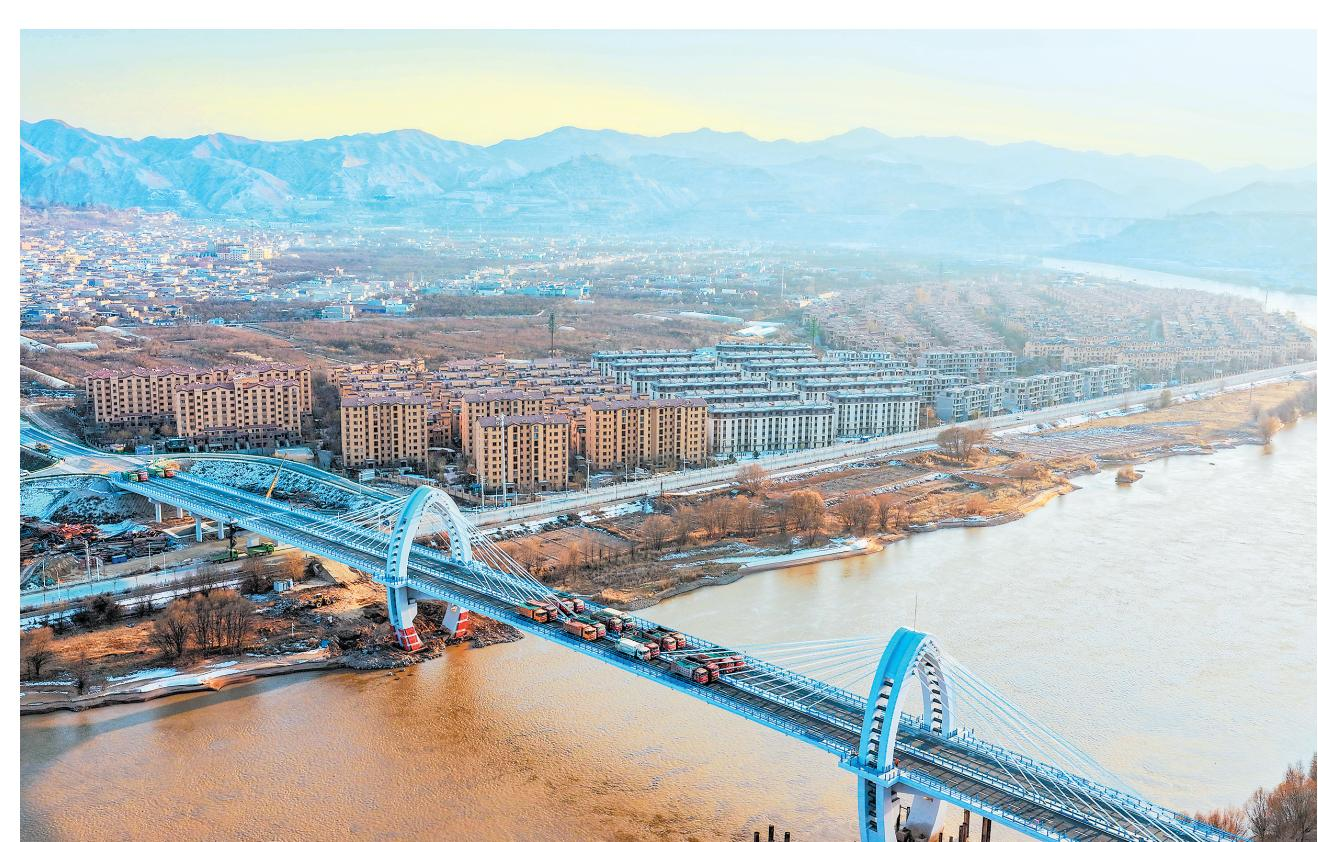
12月9日,由兰州交发建昌公司承建的兰州什川黄河大桥荷载试验圆满通过,标志着大桥主体结构已具备通车条件。
