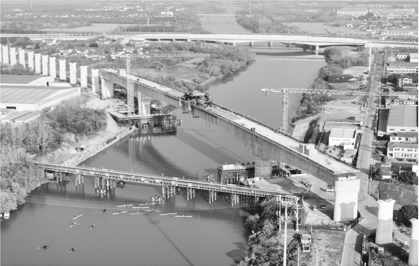
12月6日,沪渝蓉高铁通泰扬特大桥跨太平河桥实现精准合龙,为全线贯通奠定坚实基础。
