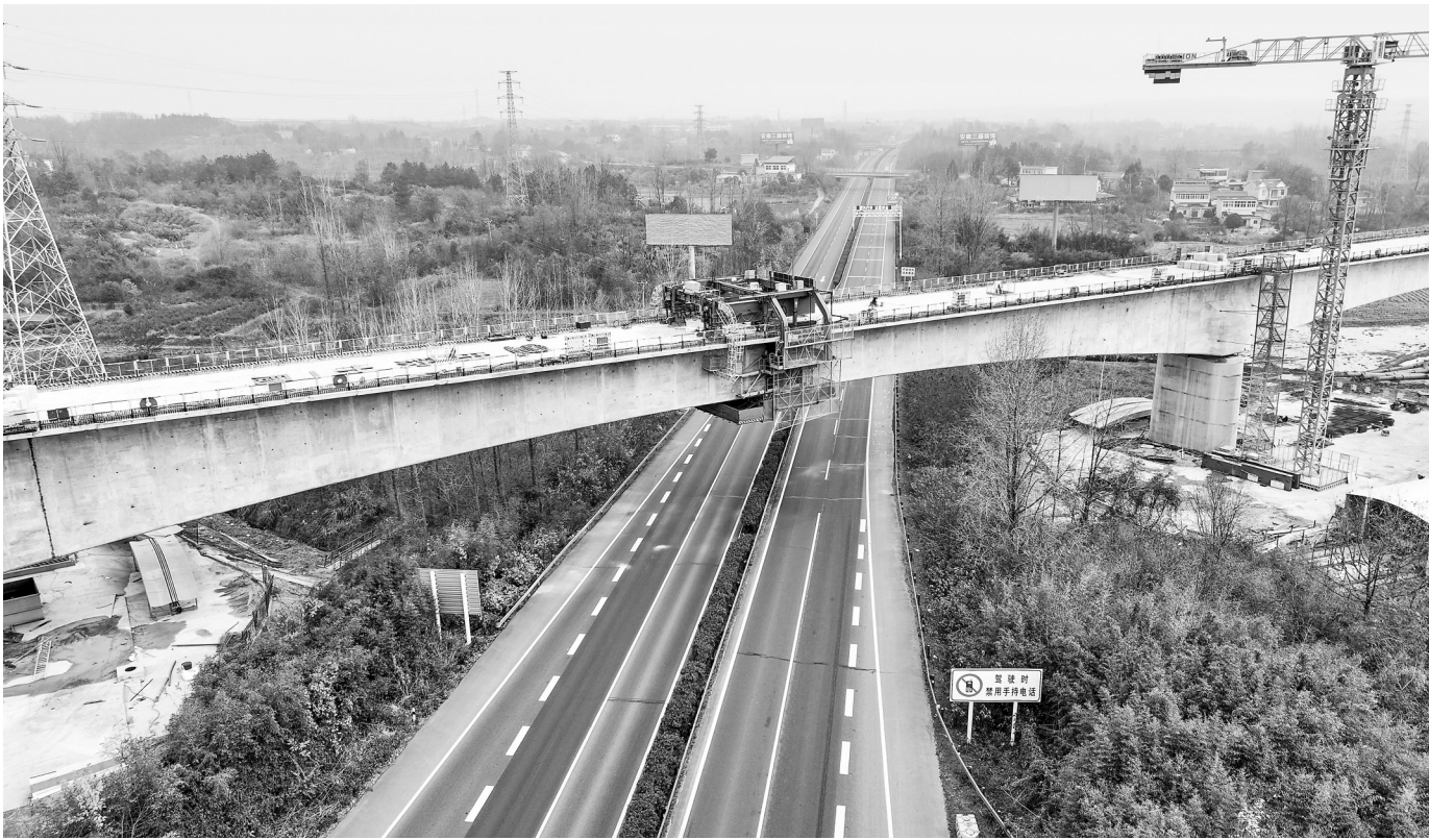
12月2日,随着最后一车混凝土浇筑完成,由中铁十一局承建的合武高铁跨沪蓉高速特大桥顺利实现合龙,标志着项目建设取得阶段性成果,为全线按期建成通车奠定了坚实基础。图为合龙后的合武高铁跨沪蓉高速特大桥。
