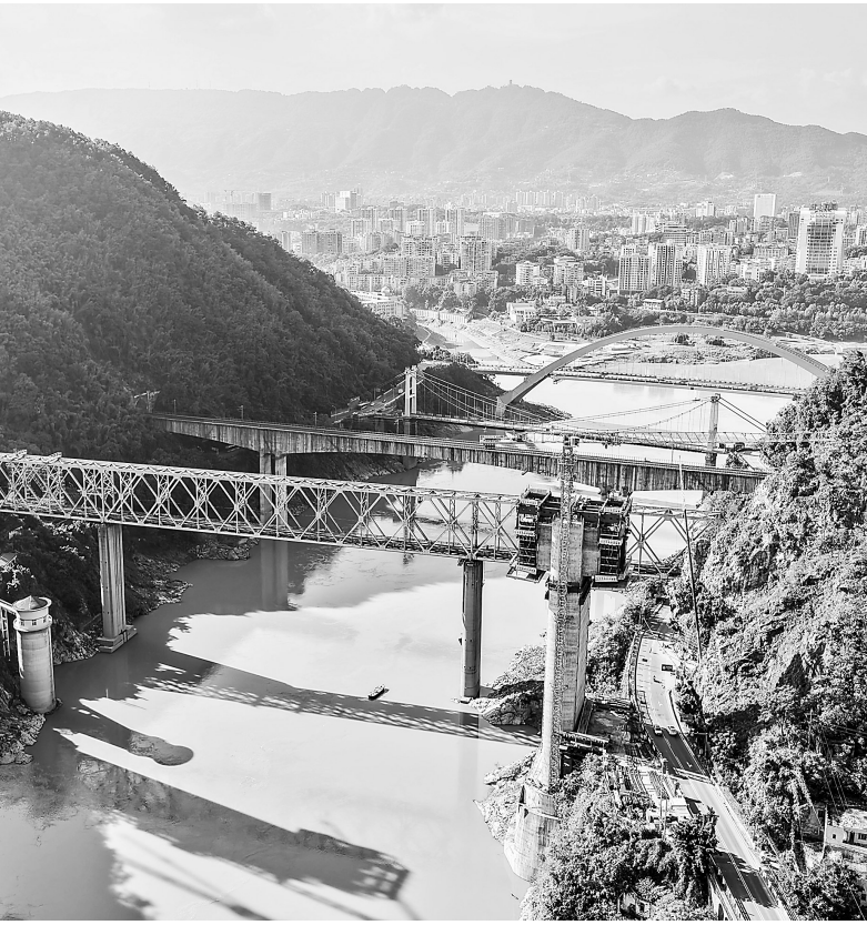
10月28日,随着新一代智慧悬臂造桥机的成功架设,西渝高铁嘉陵江特大桥进入桥面施工阶段,这也是智慧悬臂造桥机在西南地区斜拉索桥施工中首次成功应用,改变了传统挂篮依赖人工的作业模式。 新华社发
