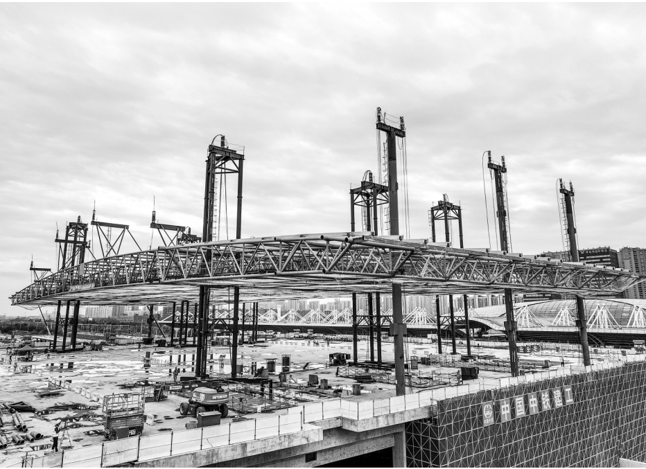
10月19日，由中铁建工承建的新建上海至南京至合肥高速铁路南通站高架站房钢结构顺利提升至预定位置，标志着站房建设进入新阶段，为后续金属屋面、幕墙及装饰装修施工奠定坚实基础。图为当日拍摄的该站房钢结构提升作业现场。 新华社记者 季春鹏
