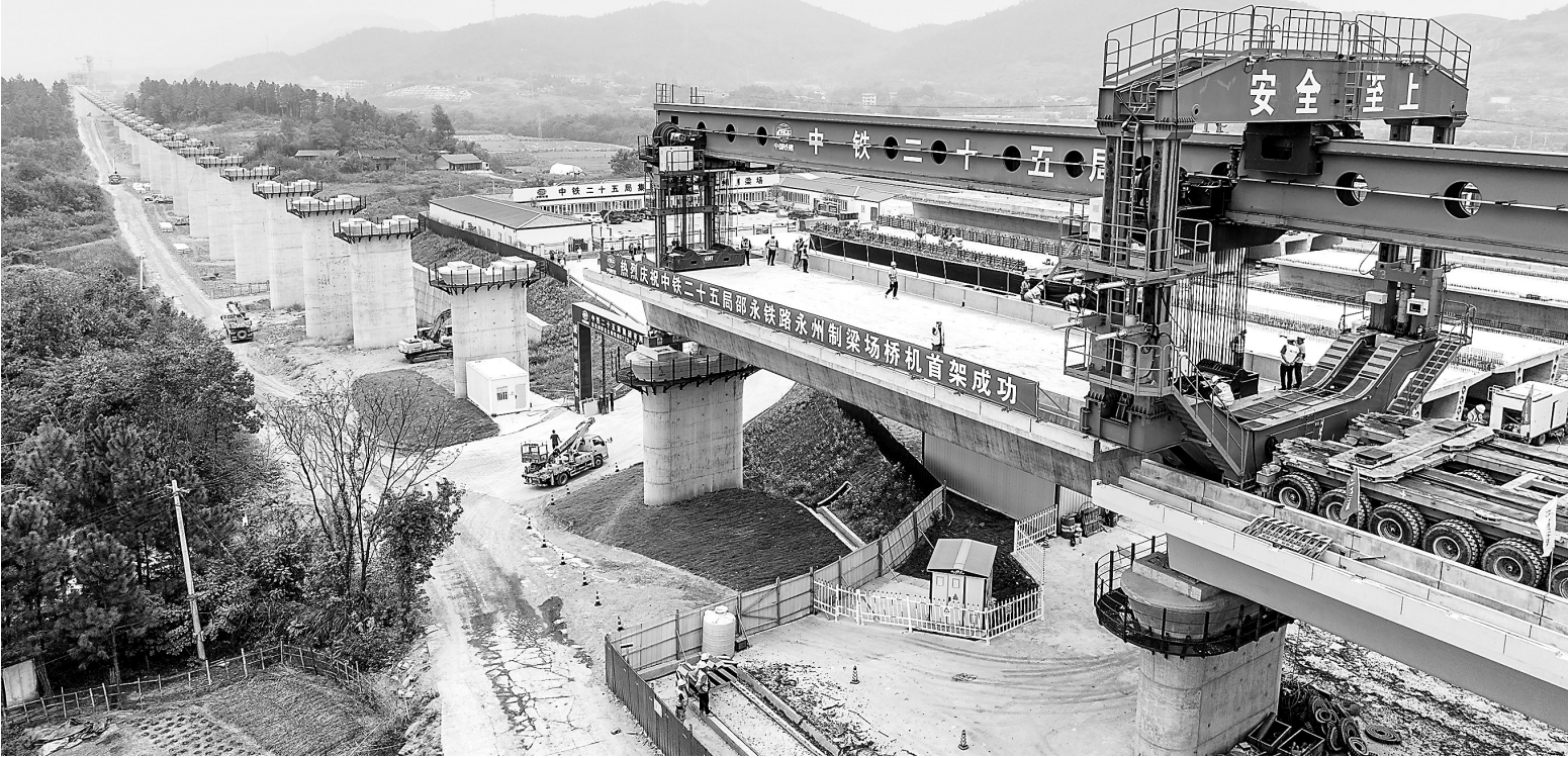
10月13日拍摄的邵永高铁跨芦洪江特大桥架梁施工现场。位于湖南省永州市的邵(阳)永(州)高铁全长约96公里,设计时速350公里,是我国“八纵八横”高铁网中呼和浩特至南宁通道的重要组成部分。
