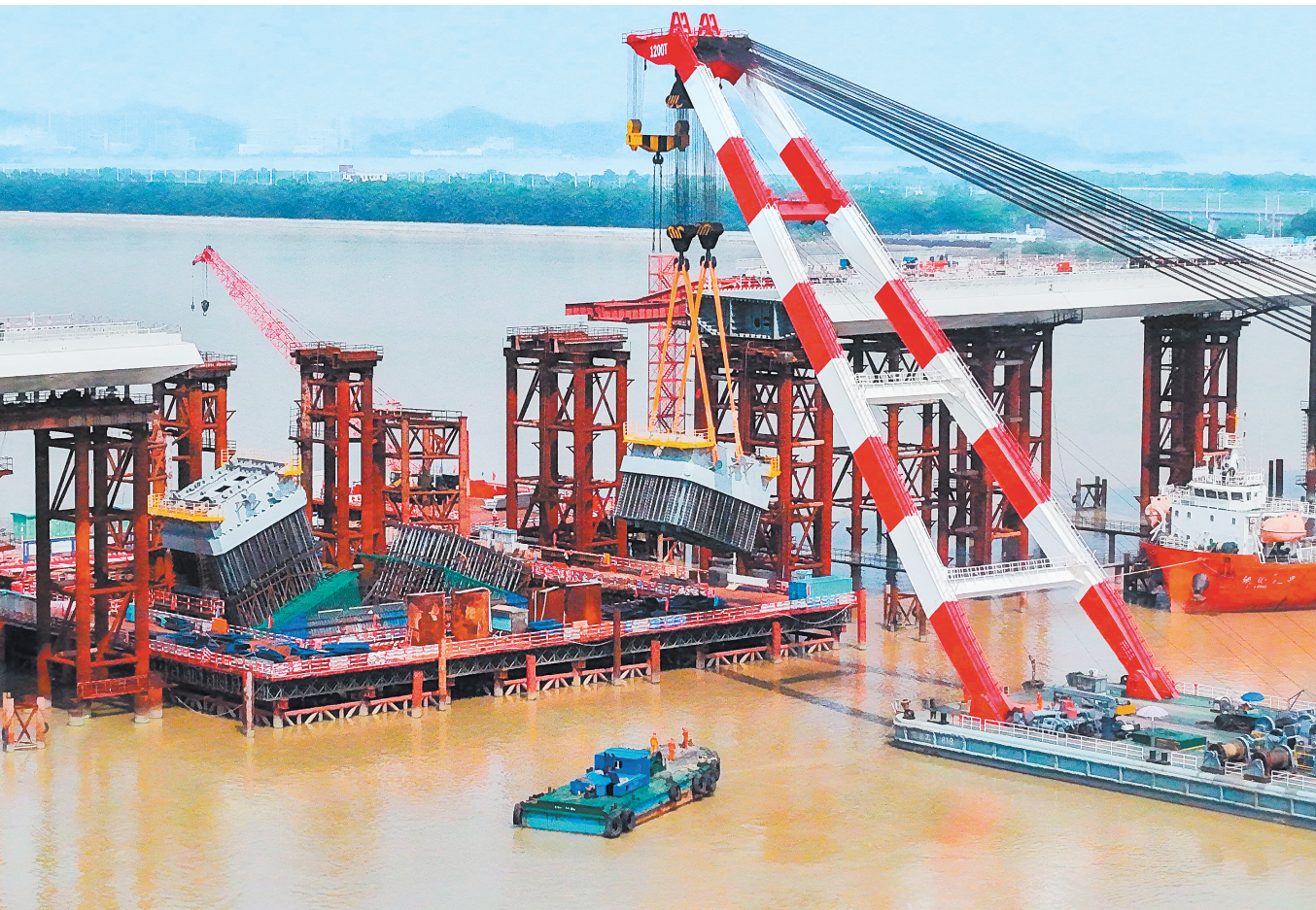
10月10日,浮吊船在珠江口吊装万龙大桥主塔首节段钢塔,这是主塔钢塔柱与混凝土塔座的过渡关键结构。位于广州南沙区的万龙大桥跨越珠江口龙穴南水道,全长5146米,主桥长1150米,主跨608米,为粤港澳大湾区又一世界级桥梁。
