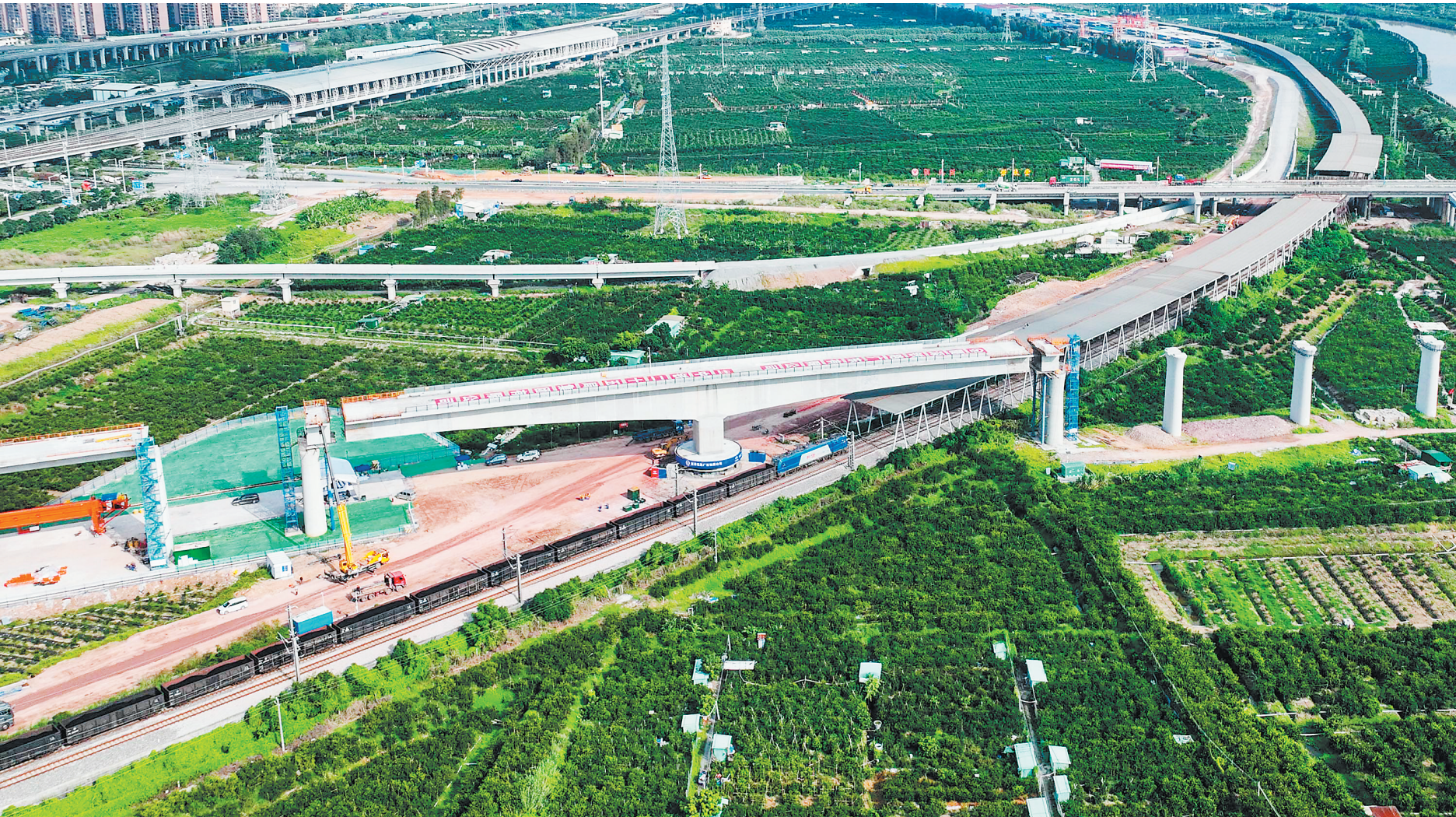
10月10日,由中铁二十五局承建的深江铁路广中江特大桥跨广珠货运铁路转体桥成功转体。图为一列货运列车从该转体桥下驶过。 新华社发
