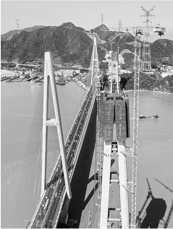
10月6日,由中国铁建大桥局承建的甬舟铁路桃天门公铁两用大桥6号主塔顺利合拢,标志着该项目关键控制性工程取得重大突破,为后续桥梁上部结构施工奠定坚实基础。
