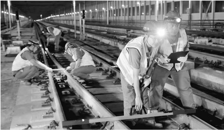
△10月4日,中铁十六局铁运公司维保人员在重庆轨道交通十八号线检测钢轨轨距。
