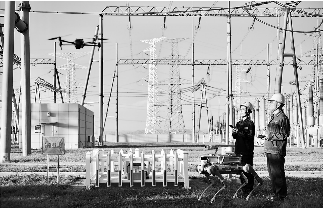
在榆中县750千伏兰州东变电站,国网甘肃超高压公司运维人员使用多种设备进行巡检。
