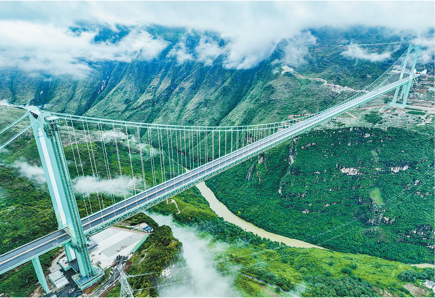
9月26日,花江峡谷大桥如同“钢铁巨龙”腾跃峡谷之上。花江峡谷大桥全长2890米,主跨径1420米,是目前世界山区峡谷第一大跨度钢桁梁悬索桥;其桥面距水面垂直高度625米,是新的世界第一高桥。该桥将于9月28日正式建成通车。 新华社发
