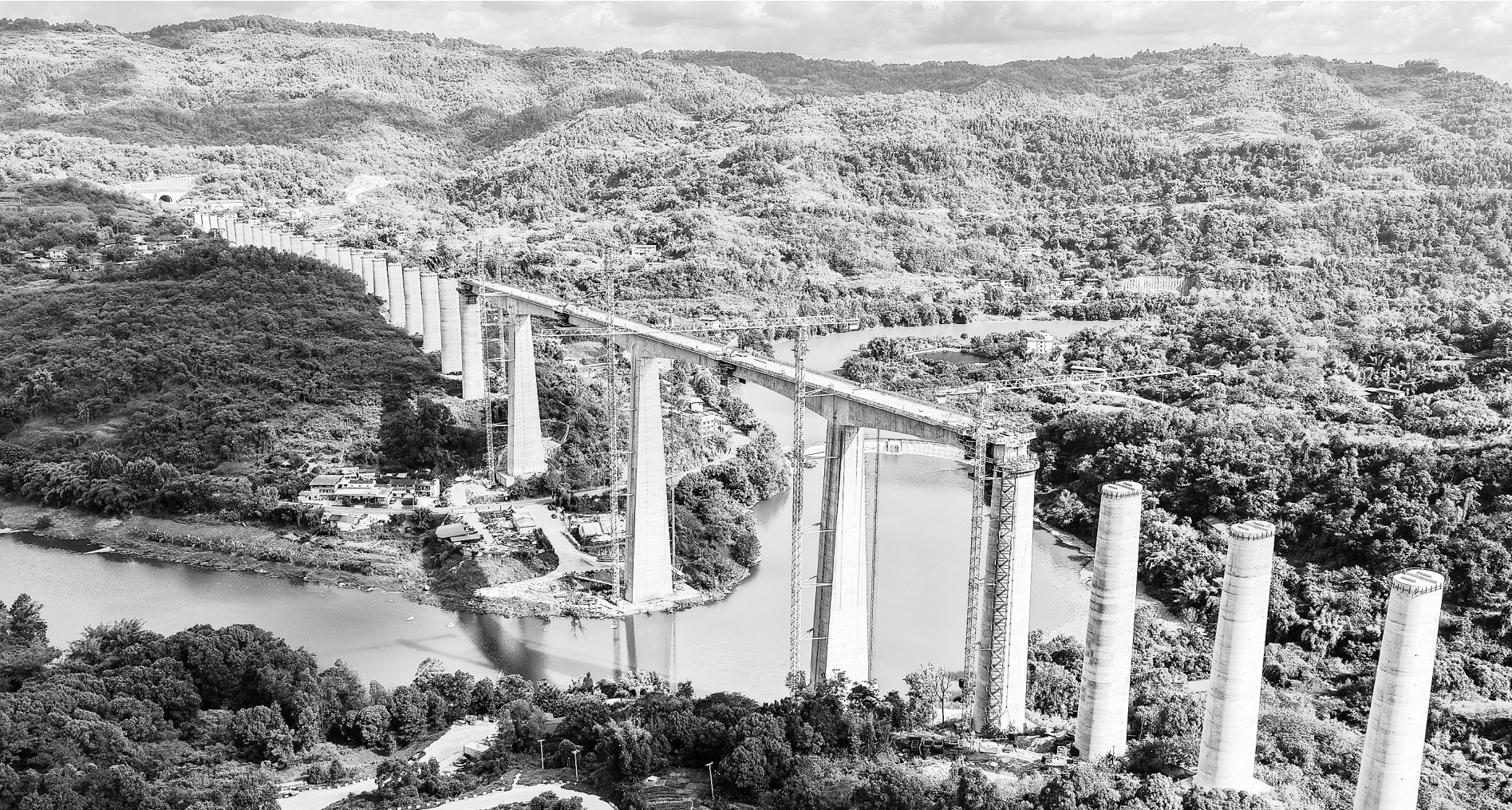
9月24日，由中铁十二局承建的渝万高铁五步河双线特大桥主跨顺利合龙，为全线按期通车奠定基础。
