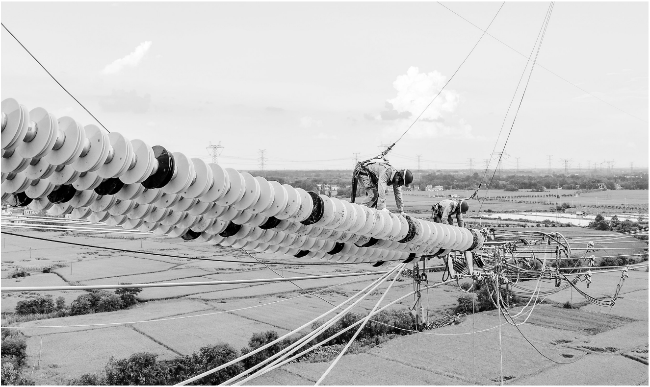
在安徽省芜湖市南陵县,安徽送变电工程有限公司施工人员在高空进行架线施工。近日,甘肃至浙江±800千伏特高压直流输电工程安徽段进入架线施工阶段。 新华社发
