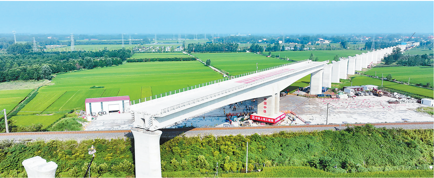
8月28日,中铁上海局的工作人员在进行雅宿高铁郛城沭河特大桥上跨胶新铁路T构梁转体作业。该转体作业顺利完成,为后续箱梁架设打下了坚实基础。 新华社发
