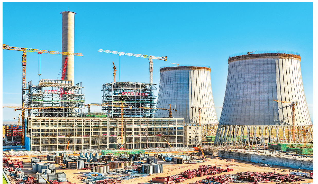
浙能武威百万千瓦级调峰煤电项目正在加快建设。
