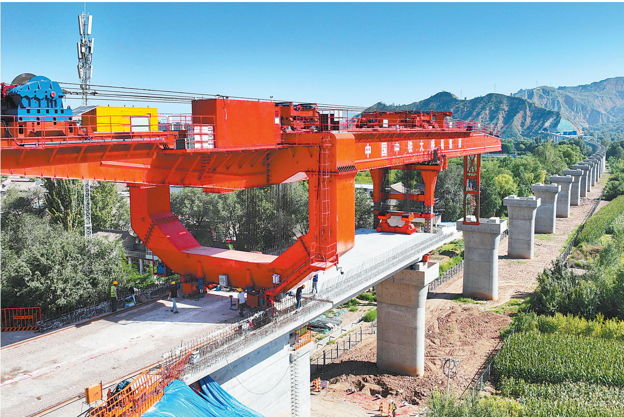
近日,由兰新铁路甘青有限公司建设、中铁大桥局承建的兰州至合作铁路站前工程LHTJ4标草滩特大桥第一片梁完成安装,为后续全面展开架梁及铁路桥面铺装工程打下坚实基础。 新甘肃·甘肃日报通讯员 史有东
