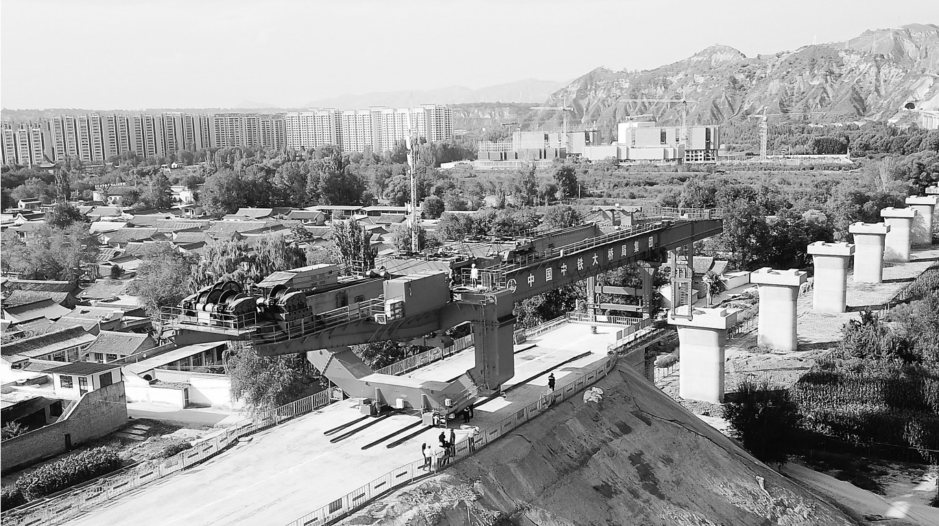
8月14日,新建兰州至合作铁路站前工程LHTJ4标的临复制梁场架桥机设备通过验收。
