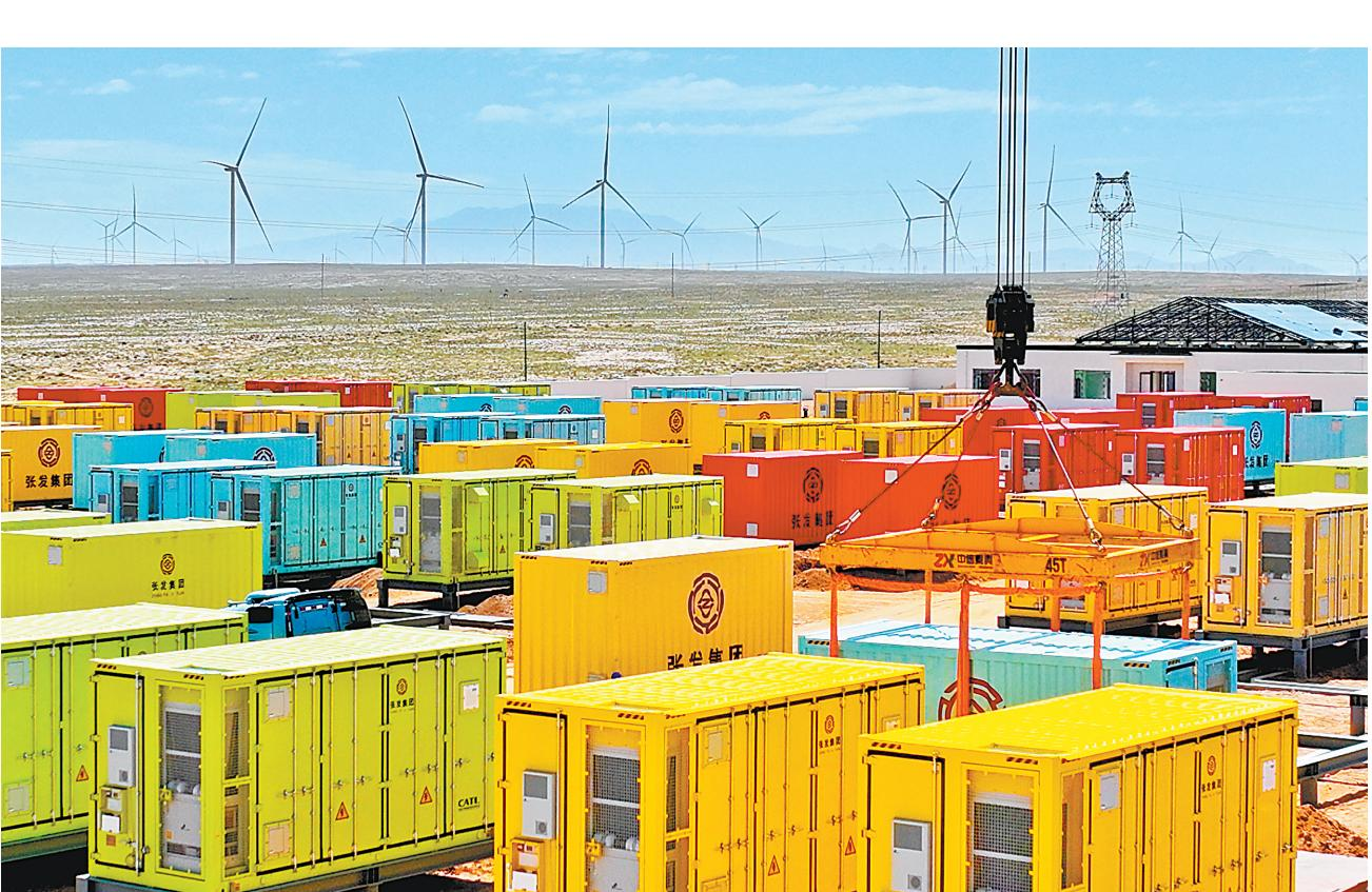
8月12日,临泽县北部滩新能源产业园内,300MW/1200MWh独立共享储能电站的储能电池集装箱正在吊装,预计共享储能电站将于10月建成运行。
