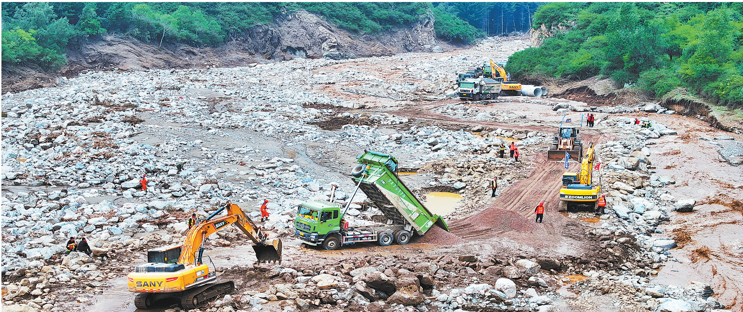
8月9日,救援人员在榆中县马坡乡马莲滩村、上庄村受灾道路埋设管涵、架设便桥,全力抢修交通基础设施。 新甘肃·甘肃日报记者 田蹊
