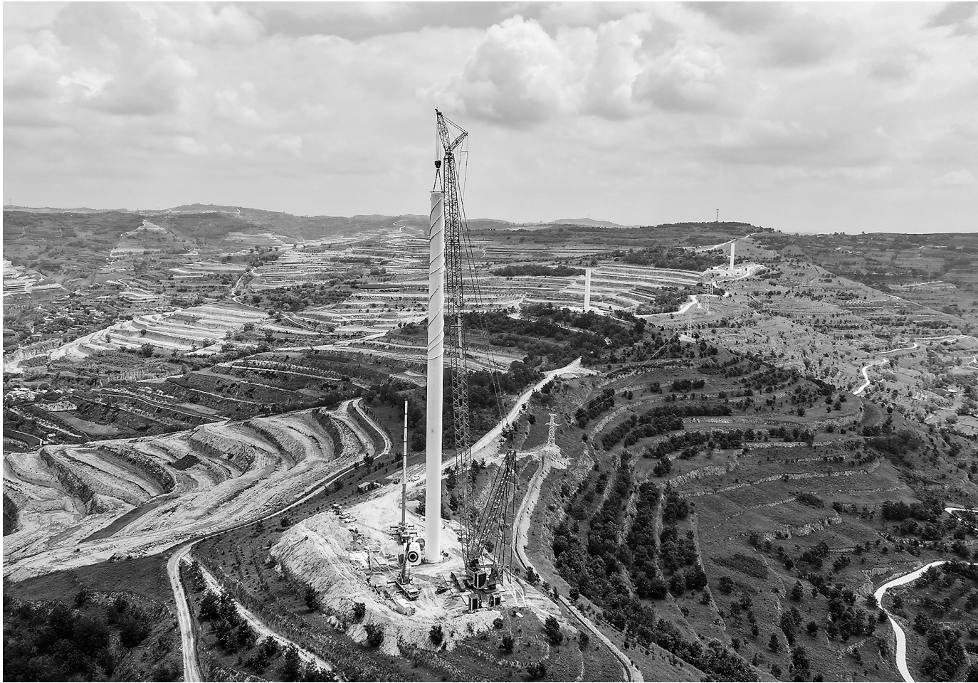
日前,通渭鸡川10万千瓦风电场高120米的风机主杆完成吊装。
