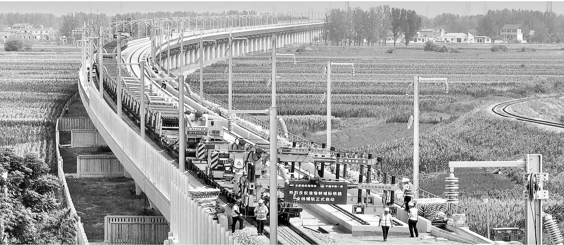
8月6日,中铁一局施工人员在安徽省淮宿蚌城际铁路铺轨施工现场作业。当日,在淮宿蚌城际铁路铺轨施工现场,中铁一局施工人员将首对500米长钢轨铺设在无砟轨道上,标志着淮宿蚌城际铁路全线开始铺轨。
