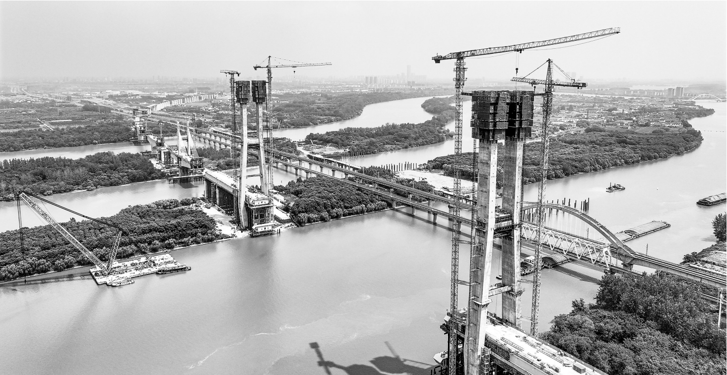
8月5日,位于江苏扬州境内的沪渝蓉高铁跨京杭运河斜拉桥建设现场。当日,由中国铁建大桥局承建的沪渝蓉高铁跨京杭运河斜拉桥主塔顺利封顶。至此,大桥核心支撑结构施工圆满收官,项目全面转入钢梁及斜拉索安装新阶段。
