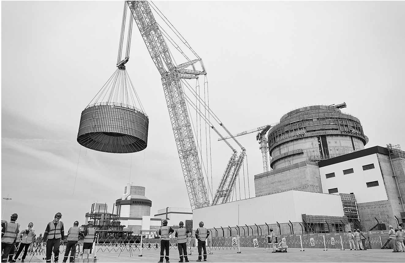
这是8月4日拍摄的山东海阳核电3号机组核岛CB20模块吊装现场。当日,国家电投山东海阳核电站3号机组核岛CB20模块顺利吊装就位,标志着该机组大型模块全部吊装完成,开始进入设备安装调试阶段。
