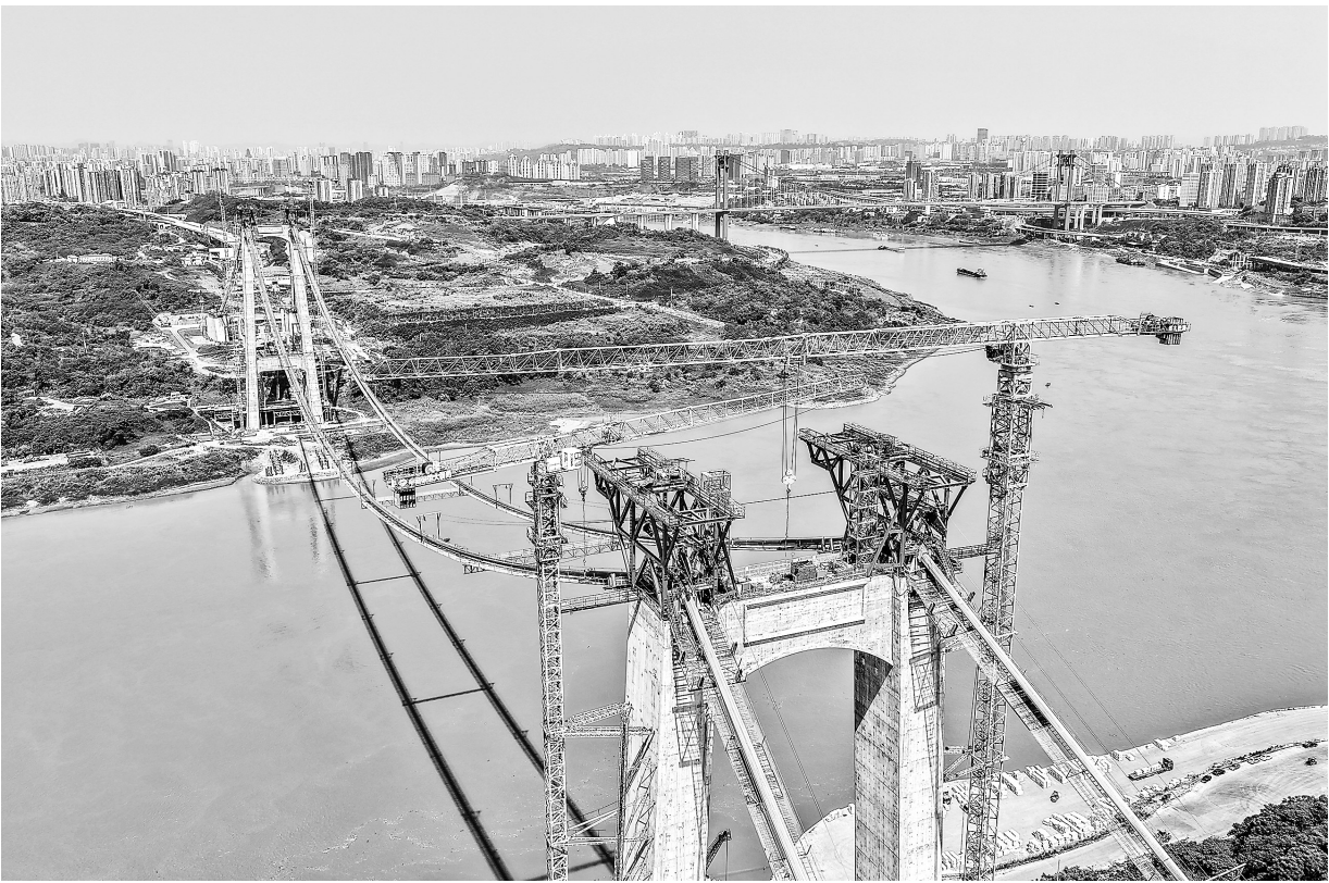
7月30日，重庆黄桷沱长江大桥顺利完成主缆架设工作，标志着大桥建设即将进入钢桁梁吊装工序。黄桷沱长江大桥全长1260米，主跨765米，是国内最大跨径公轨两用悬索桥。这是黄桷沱长江大桥主缆架设作业现场。 新华社发
