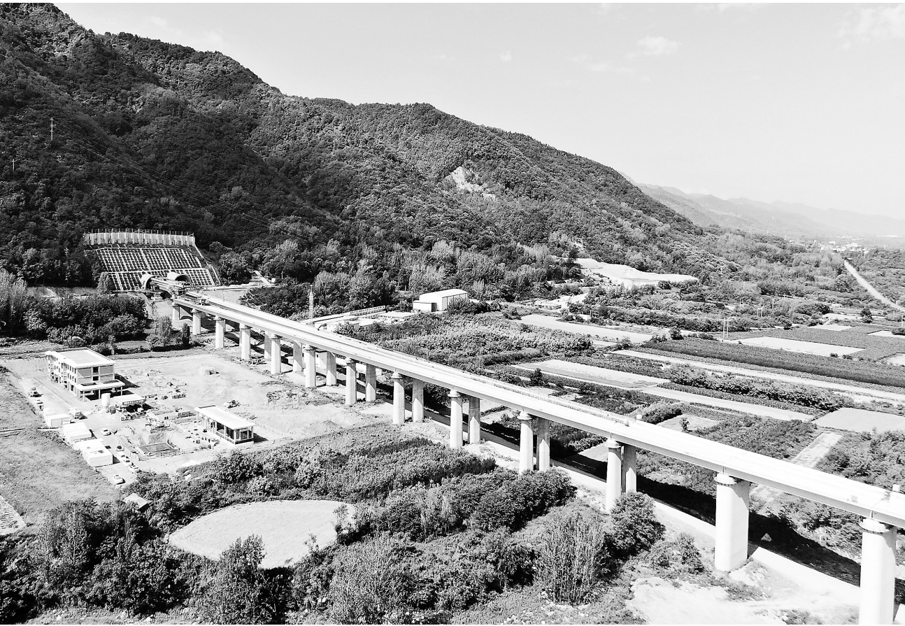
7月28日,随着架桥机将一孔长32.6米、重431.75吨的箱梁平稳落在西康高铁跨关中环线立交特大桥墩台上,西康高铁桥梁架设任务全部完成,为后续施工奠定坚实基础。图为正在架设最后一孔箱梁的西康高铁跨关中环线立交特大桥。
